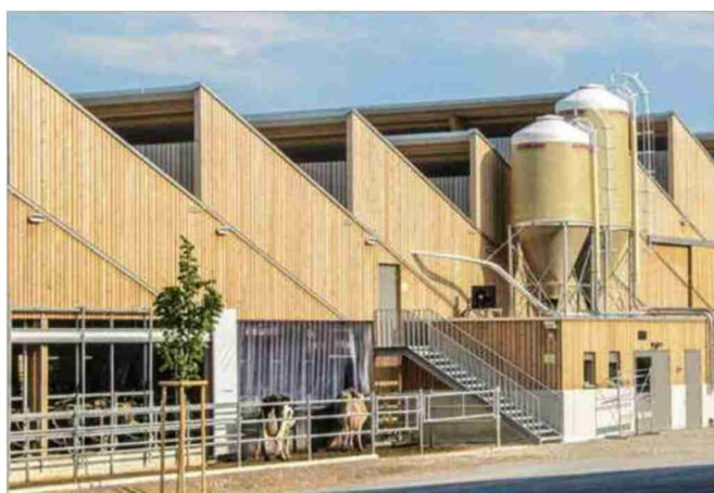
Auslauf vor dem Kuhstall: Der neue, moderne Milchviehstall mit dem Shed-Dach. (Bild: zvg)
