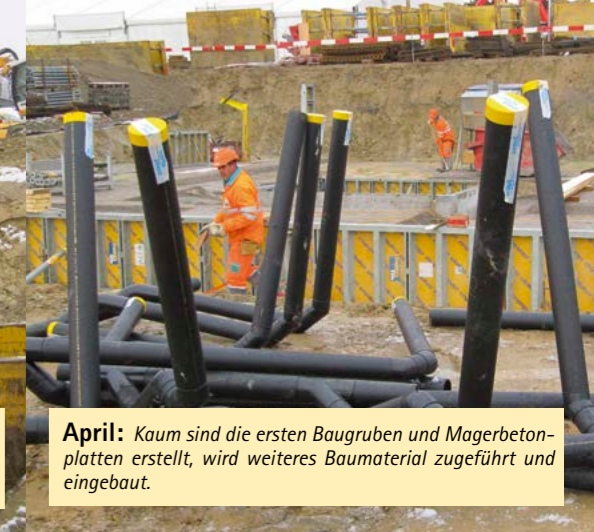
März: Unzählige Leitungen für Wasser, Abwasser, Energie und Kommunikation werden verlegt. Das nasse Wetter erschwert diese Arbeiten.
