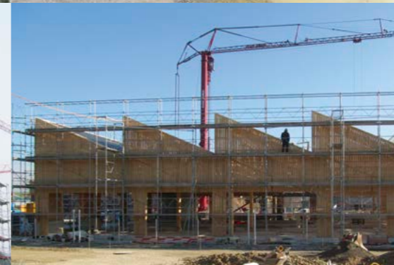
Oktober: Milchviehstall von Westen her gesehen. Die ersten Gebäudeansichten im «Shed-Stil» sind erstellt – das Markenzeichen von Agrovet-Strickhof.
