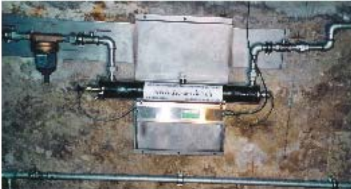
Wasserdurchlaufstrahler auf einer Alp mit 240 Volt
