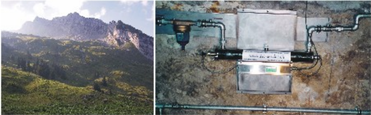
Beispiel: Wasserdurchlaufstrahler auf einer Alp mit 240 Volt
